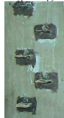
Фото 2. Уплотнение Hygrostop-Суперэластичным 2 \text{ кг/м}^2 стыка проникающего покрытия с металлическими ступеньками пожарного резервуара.
