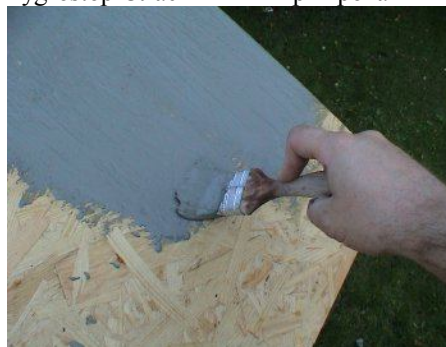
Фото 2. Гидроизоляция водостойкой плиты ДСП Hygrostop-Эластичным 1кг/м 2 .
