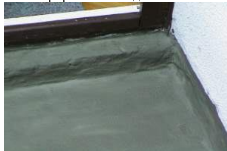
Фото 1. Гидроизоляция Hygrostop-Эластичным 2,0кг/м 2 , тонкой стяжки утепленной террасы, на которой могут возникнуть трещины. Стяжка толщиной около 4см, армированная сеткой.
