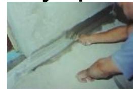
Фото 3. Гидроизоляция стыка плиты утепленной террасы со стеной полосой покрытия, шириной 10см.
